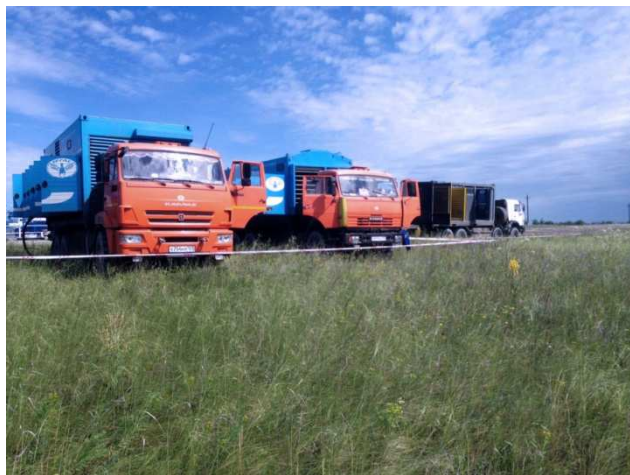
Рисунок 2. Испытания магистрального газопровода пневматическим методом: компрессорная техника развернута на рабочих позициях
