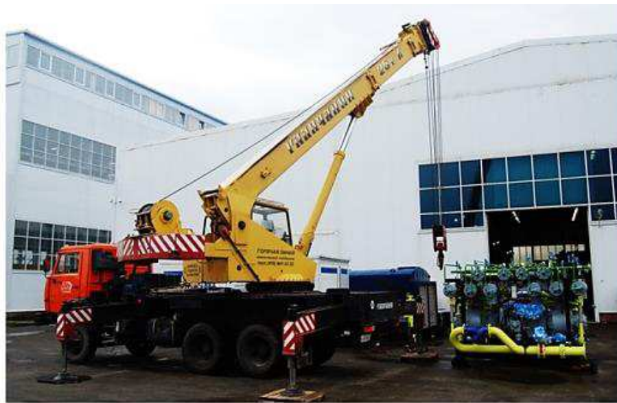
Рисунок 3. Погрузка углекислотной компрессорной установки производства ККЗ
