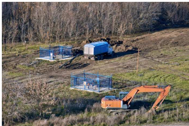
Рисунок 4. Азотная компрессорная станция ТГА-10/251 у крановых узлов магистрального трубопровода выполняет задачу по испытанию участка
